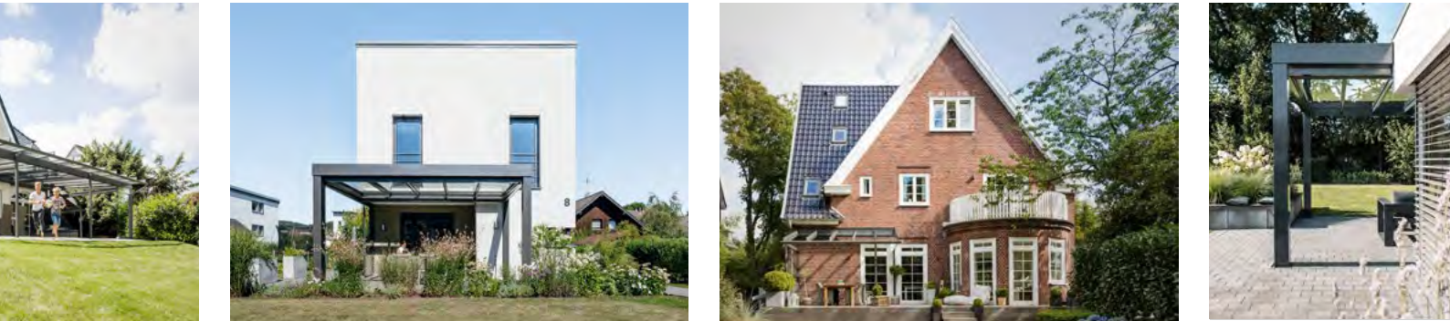
Terrassendächer: größte Öffnungen verbinden innen und außen
